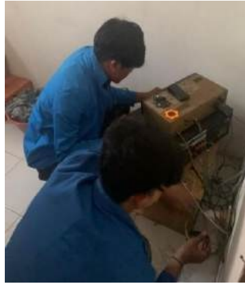
Gambar 3 proses pemasangan amplifier
