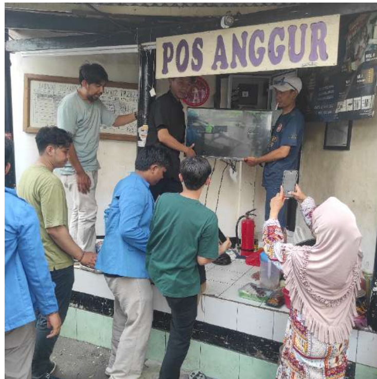
Gambar 3. Praktik Instalasi cctv Secara Langsung kepada Warga RT. 3
