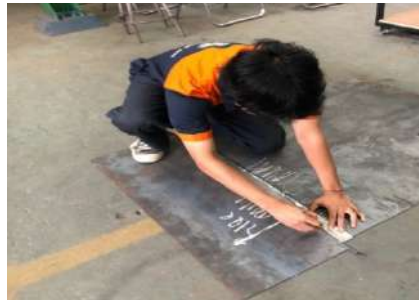
Gambar 11. Pengukuran Plat Besi
